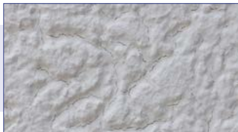
Beschichtung mit Schrumpfrissen.
